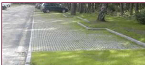
Traitement vertueux des stationnements
